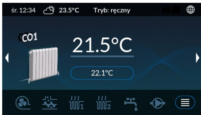
Ilustracja 11: Ekran obwodu CO.1
